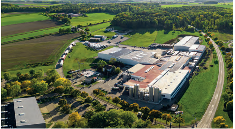
Aus der Vogelperspektive: Betriebsgelände der Molkereigenossenschaft in Schrozberg im fränkischen Teil Baden-Württembergs
