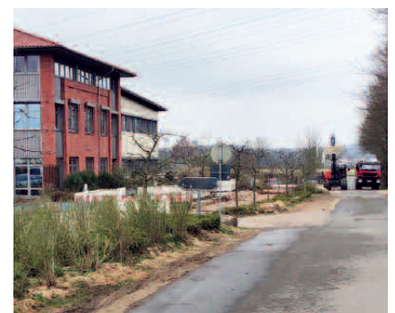
Der erste Baggeraushub für die Betriebserweiterung
